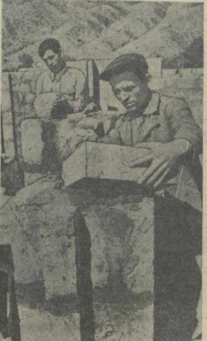
На строительстве подстанции Большой Дядубе. На снимке (слева направо): станочники каменщик П. Петров и бригадир Я. Беграшвили за кладкой шлакоблоков, из которых строится здание трансформаторной мастерской.
