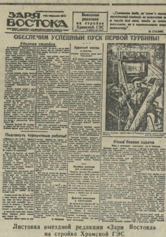
Листовка выездной редакции «Зари Востока» на стройке Храмской ГЭС
