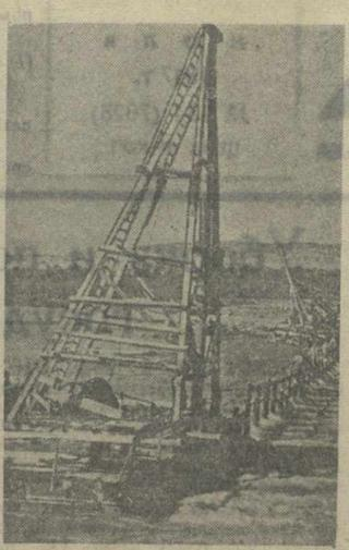
В районе города металлургов Рустави строится большое водоаборное сооружение для обеспечения технических нужд Закавказского металлургического завода водой. На снимке: строительство перемычки. Фото В. Тархова.
