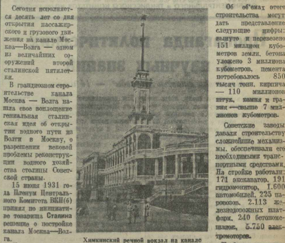
Химкинский речной вокзал на канале Москва-Волга в Москве.
