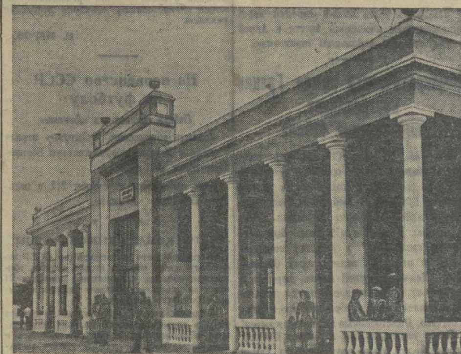
Новое здание пассажирской станции Кутаиси-вторая, обслуживающей курортников Цхалтубо и строителей автомобильного завода.
