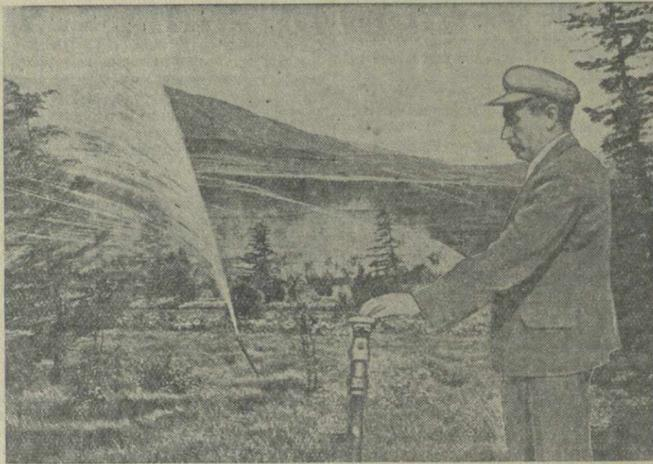
В Ваке, на территории нового парка, проводились испытания дождевых аппаратов, сконструированных и изготовленных Грузинским научно-исследовательским институтом гидротехники и мелiorации. Для получения искусственного дождя используется пароводы Черепашьего озера и воды реки Веры, подаваемой насосами.
