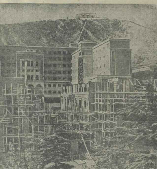
Строительство фасадной части Дома правительства значительно продвинулось вперед. В первом крыле здания перекрыт купол восточной и восточно-бетонирование пола. На уровне четвертого этажа возводятся стены будущего большого зала Верховного Совета Грузинской ССР.
