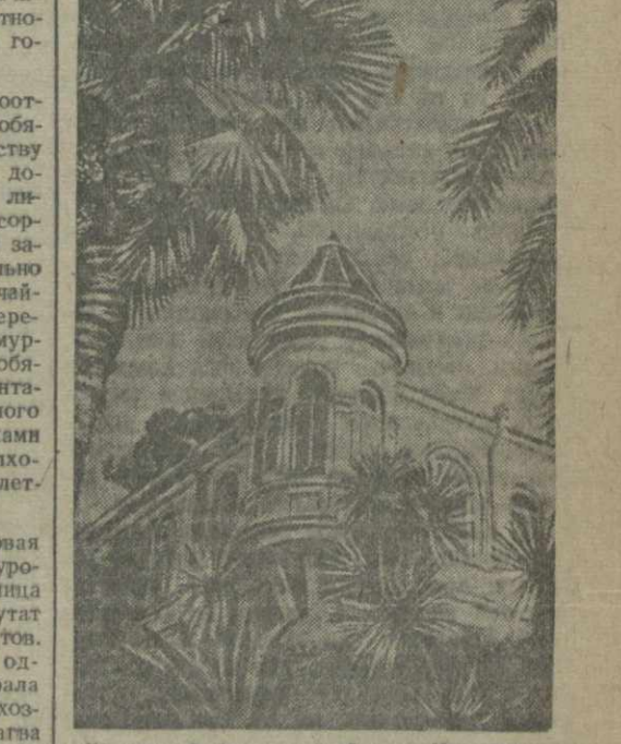
Батумский ботанический сад. На снимке здание, в котором помещаются научные кабинеты и лаборатория.
