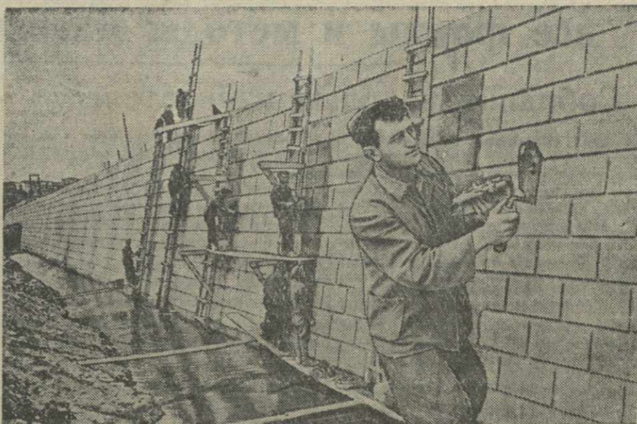
Строительство набережной на левом берегу Куры. На снимке: облицовка подпорной стены. Фото М. Квирикашвили.
