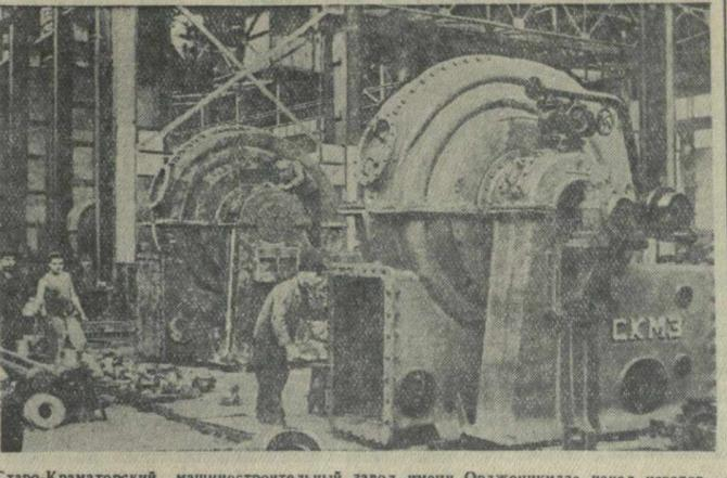
Старо-Краматорский машиностроительный завод имени Орджоникидзе начал изготовлять десинтераторы для мюкром тонкой очистки доменного газа от пыли. Производительность десинтератора 60 тысяч кубометров в час. На снимке: монтаж десинтераторов. Фото И. Бондаренко. Фотохроника ТАСС.
