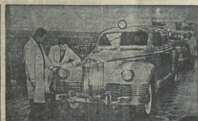
Московский автомобильный завод имени Сталина в третьем послевоенном году пятилетки начал серийный выпуск легковых санитарных автомобилей «ЗИС-110». Автомобили «Скорая медицинская помощь» предназначены для перевозок больных. На снимке: конвейер сборки легковых санитарных автомашин. На переднем плане — старший мастер ОТК Л. Л. Розенталь (слева) и слесарь-водитель Г. В. Лукоперов за осмотром сошедшей с конвейера автомашины «ЗИС-110». Фото Б. Пушкина. Фотохроника ТАСС.
