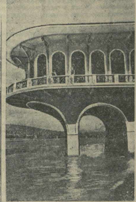
В одном из живописных уголков парка культуры и отдыха имени Орджоникидзе, началось строительство ресторана-павильона. Ресторан построен по проекту архитекторов Г. Чачанидзе и А. Волффенсона. Он имеет открытую веранду, выделяется оригинальной архитектурой. На снимке: ресторан-павильон над Курой. Фото М. Квирикашвили.
