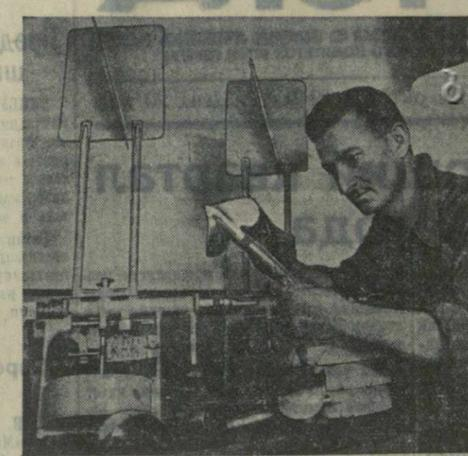
Тбилисский завод гидрометеорологических приборов. На снимке: слесарь-сборщик Шалава Хуцишвили за сборкой речных вертушек—приборов, определяющих скорость движения и направление верхних слоев воды в реках. Фото М. Кварццвашвили.
