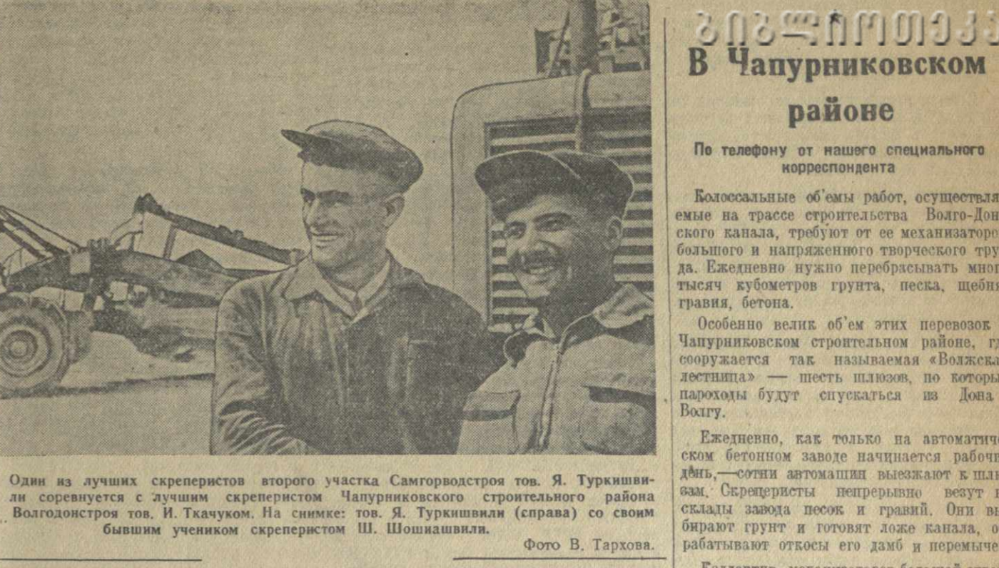
Один из лучших скреперистов второго участка Самгорводстроя тов. Я. Туркишвили соревнуется с лучшим скреперистом Чапурниковского строительного района Волгодонстроя тов. И. Ткачуком. На снимке: тов. Я. Туркишвили (справа) со своим бывшим учеником скреперистом Ш. Шопиашвили. Фото В. Тархова.
