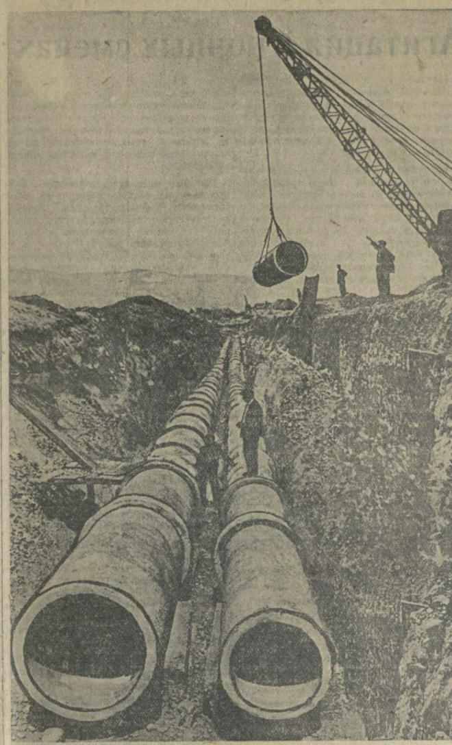
На трассе строительства Булачаурского водопровода. Бетонный комбинат Замкеллургстроя изготавливает для нового водопровода железобетонные трубы большого диаметра. На снимке: укладка этих труб в траншею. Фото М. Квирикашвили.
