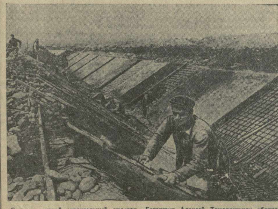
Самгори, второй строительный участок. Бетонщик Алексей Тамарашвили обильно выкладывает откосы канала. Фото В. Тархова.
