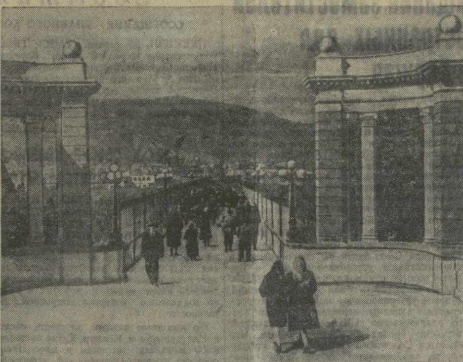
23 апреля открылось движение по новому пешеходному мосту, соединившему кратчайшим путем Вокзальную площадь с Советской улицей. Строительство моста закончено досрочно.
