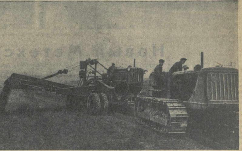
Сегодня в Самгори. На снимках: 1. Установка опалубки трубы дюкера на участке Первой строительной конторы; 2. Работа землеройной машины-кавакопателя. Фото В. Тархова.
