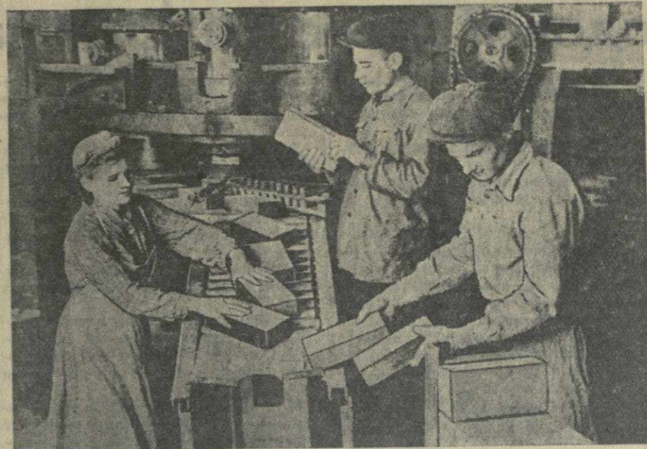
На Сабуртальском механизированном заводе сухого прессования кирпича. На снимке: в прессочном отделении формовочного цеха. Слева направо — сменщик К. Вальчишина, прессовщик Ш. Дзамашвили и откатчик Н. Яковенко. Фото К. Крымского.
