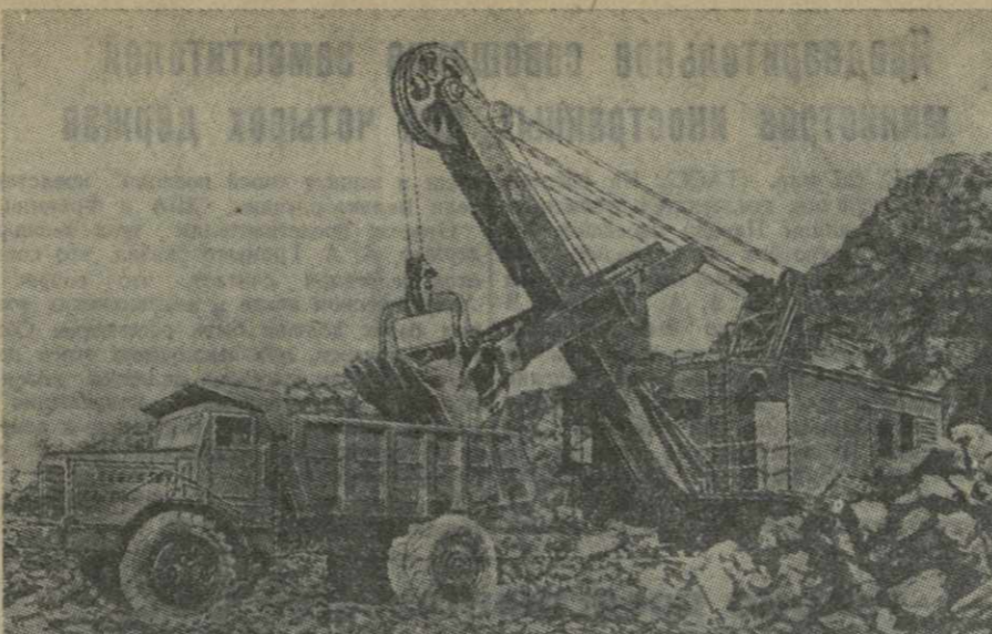
Новая техника на великих стройках. На строительстве Волго-Донского судоходного канала работают сверхмощные 25-тонные автосамосвалы Минского автозавода...
