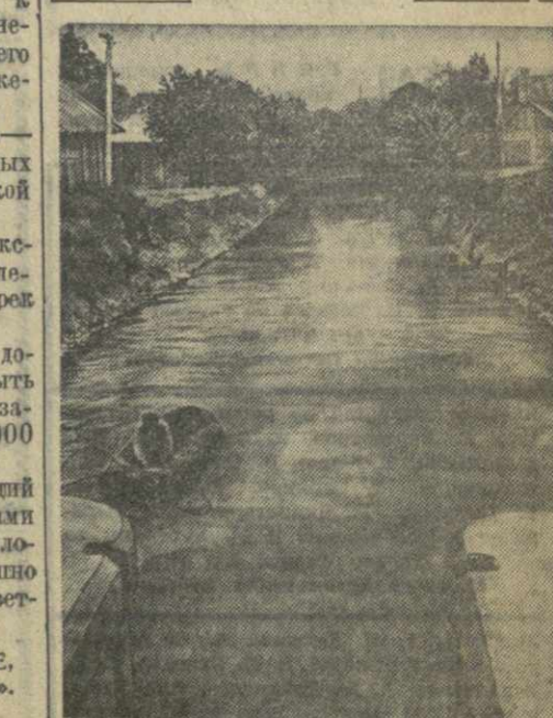
Министерство водного хозяйства закончило реконструкцию головных сооружений Тшинокари оросительного канала. Этим положено начало реконструкции всей Тшинокари оросительной системы и строительству второй очереди, которая орошит 18 тысяч гектаров новых земель в Горьком и Каспском районах. На снимке: участок канала Тшинокари оросительной системы. Фото В. Черкасова.
