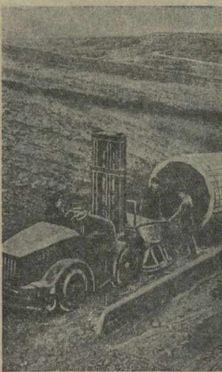
Самгори. Подача бетона автопогрузчиком для бетонировки трубы люка.
