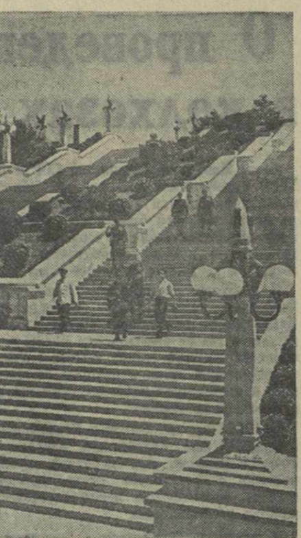
Растет и благоустраивается второй индустриальный город Грузии — Кутанси. Строятся здания, прокладываются новые улицы, разбиваются сады и скверы. На снимке: строится в текущем году лестница, ведущая к привокзальной площадке на Тбилискую улицу.
