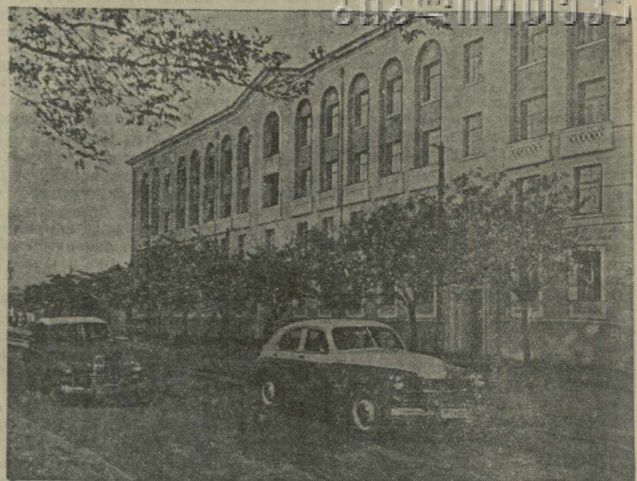
В предпраздничные дни на ул. Шаумяна закончилось строительство четырехэтажного жилого дома для рабочих, инженерно-технических работников и служащих Трамвайно-троллейбусного управления. В доме — восемь трехкомнатных квартир и 49 отдельных комнат, предназначенных для общестных. Девяносто шесть человек справят в новом доме новоселье в дни праздника. Среди новоселов — стахановец-компрессорщик Константин Кинадзе, вагоновожатая Антонина Воробьева, сборщик-ремонтёр троллейбусов Александр Урткемадзе, инженер Е. Катамадзе и другие. Фото В. Тархова.
