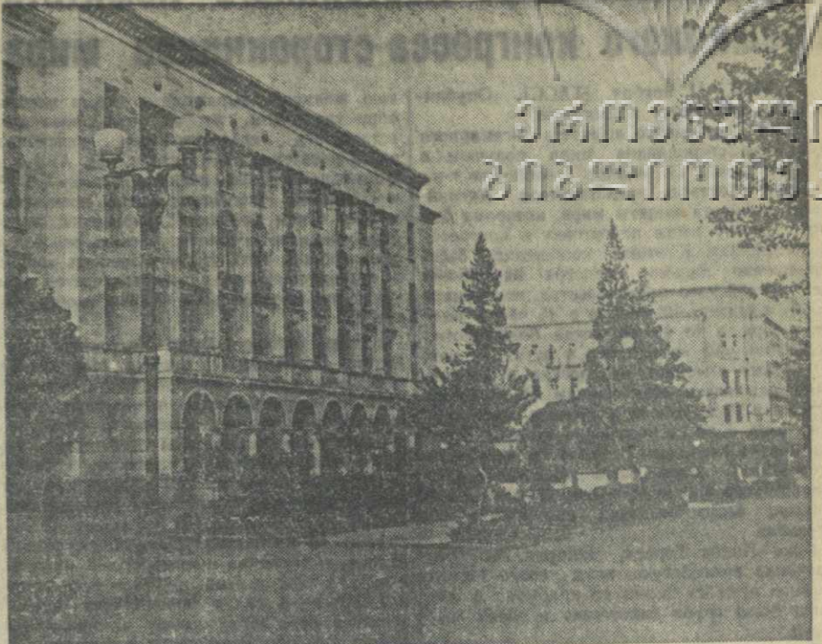
Административный дом в Кутаиси, построенный по проекту архитектора М. К. Шавишвили.
