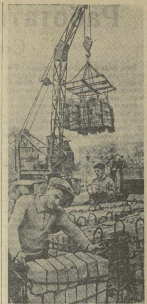
Грама-Гельский кирпично-бетонный комбинат треста Закамалдурстрой. На снимке: стахановец И. Сулашвили (на переднем плане) укладывает кирпич в контейнеры перед отправкой на стройку. Фото М. Квирикашвили.
