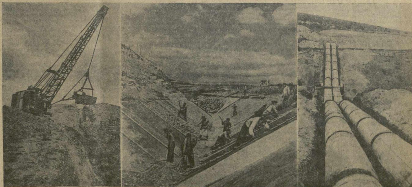
На строительстве Самгорской оросительной системы. На снимках (слева направо): экскаватор производит засыпку дювера; лучшая бригада бетонщиков Нико Мирабишвили ведет облицовку канала; вид на дюкер.
