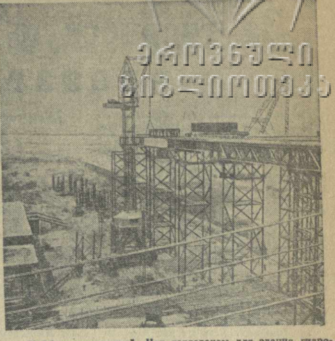
Кубышаегидрострой. Над котлованом для здания гидроэлектростанции на высоте 40 метров сооружается бетонная астакада. На ней монтируются стальные пути, по которым будут двигаться порталные краны и мотовозы, доставляющие в котлован бетон, арматуру и различное оборудование. На снимке: строительство бетонной астакады. Фото Н. Финикова. Фотохроника ТАСС.
