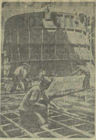
На строительстве Мингечаурского гидроузла. На снимке: установка детали одной из турбин гидростанции. Фото С. Кулишова. «Советский Союз».
