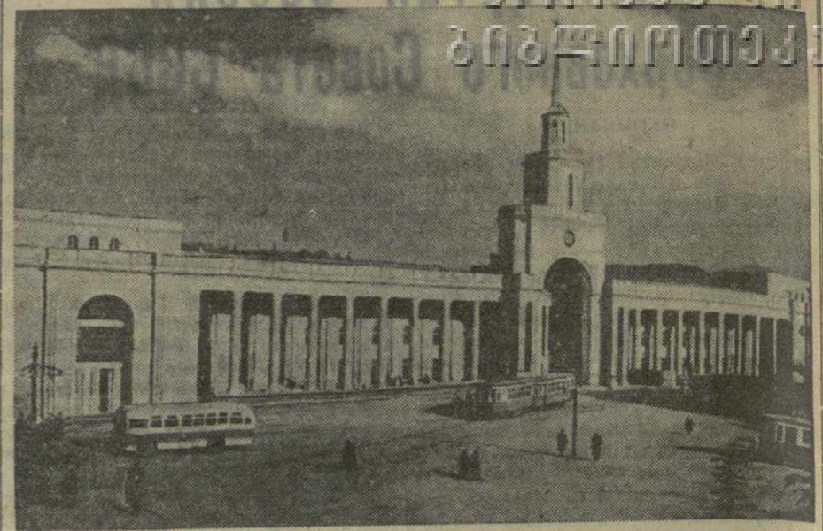
Закончены отделочные работы в левом крыле нового здания Тбилисского вокзала. Сейчас главное внимание строителей обращено на внутреннюю отделку правого крыла и благоустройство привокзальной территории. В новом, красивом по архитектуре здании вокзала предусмотрены все удобства для пассажиров. К их услугам будут гостиная, библиотека, благоустроенные залы ожидания, хорошо оборудованные комнаты матери и ребенка. Строители стремятся досрочно и высококачественно завершить оставшиеся работы. Бригада столяров-паркетчиков, руководимая т. З. Мангазаровым, ежедневно выполняет нормы на 160—165 проц. С большим перевышением заданий работают бригады мозаичников и бетончиков-землекопов, возглавляемые т. Н. Паниным и Ф. Капустиним. На снимке: новое здание Тбилисского вокзала. Фото В. Тархова.
