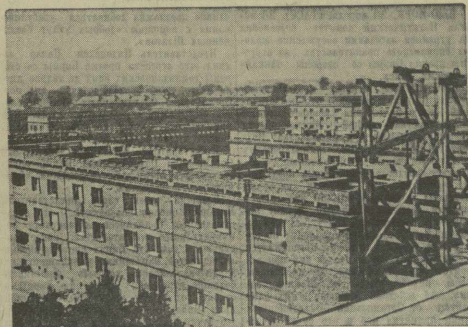
На снимке: на строительстве города Новая Гута. Фотохроника ТАСС.
