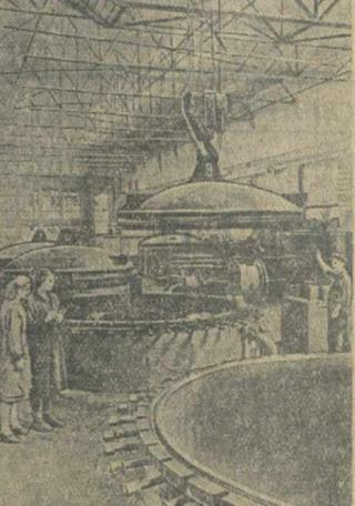
На Московском заводе «Москабель». На снимке: в сушильно-пропиточном отделении. Посадка в вакуум-аппарат силового кабеля, предназначенного для Волгодрострой. На переднем плане — начальник отделения Л. П. Старченко и мастер М. В. Харитонов.
