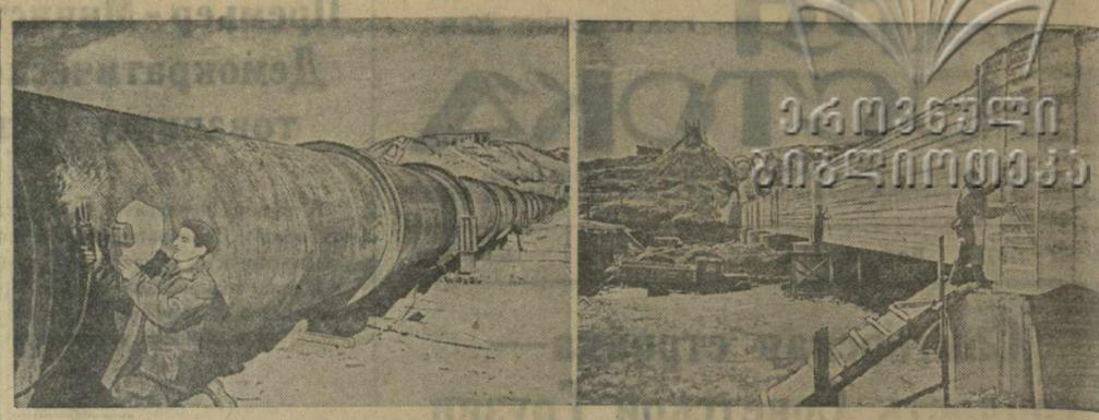
На Самгорской стройке. На снимках: 1. Электросварка трубопровода, 2. Облицовка дюкера. Фото М. Квирикашвили.
