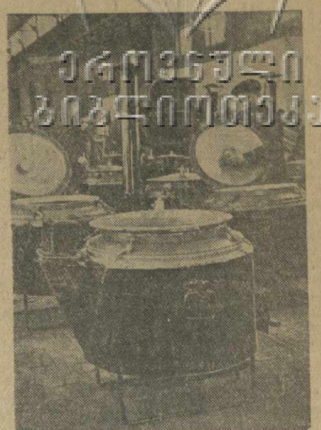
Брянская область. Коллектив Жуковского механического завода выпускает переносные кухни емкостью 150 литров. Они предназначены для отправки в районы освоения целинных земель. На снимке: в цехе сборки переносных кухонь. Фото И. Рабиновича. Фотохроника ТАСС.
