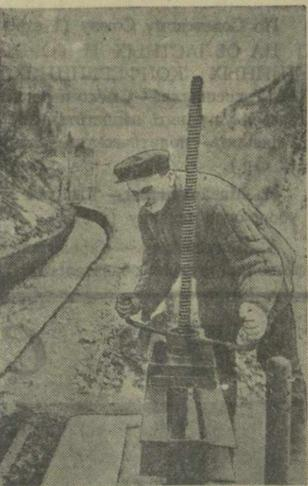
Высокогорное село Дгани Шухевского района стало одним из передовых и культурных сел Аджарии. В селе есть гидроэлектростанция, радиоузел, библиотека. На снимке: дежурный электростанции колхозной гидростанции И. Абашидзе за пуском воды к турбинам ГЭС.
