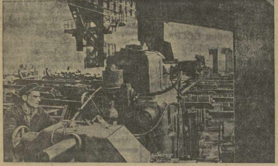
Рустави. В трубопрокатном цехе Закавказского металлургического завода имени Сталина установлены труборезные станки, изготовленные Тбилиским станкозаводом имени Кирова. Коллектив цеха успешно освоил новые станки.
