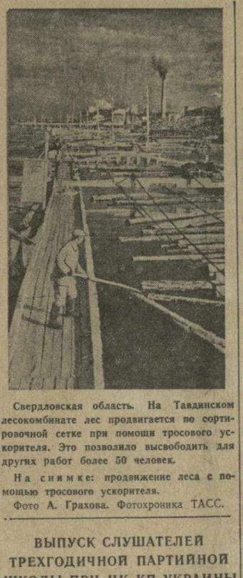
Свердловская область. На Тавдинском лесокombинате лес продвигается по сортировочной сетке при помощи трасового ускорителя.
