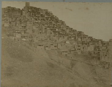
სოფ. ჯინჯიფის კლდეზე მდებარე სასახლე
