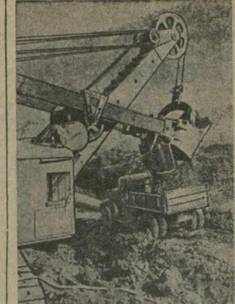
Куйбышевгидрострой. Наша промышленность вооружает великую стройку первоклассной техникой. На рывке котлована под здание Куйбышевской ГЭС работают мощные электрические и шагающие экскаваторы. На снимке: экскаватор бригадира Н. Зинкевича на рывке котлована. Фото М. Альперта, (Фотохроника ТАСС).
