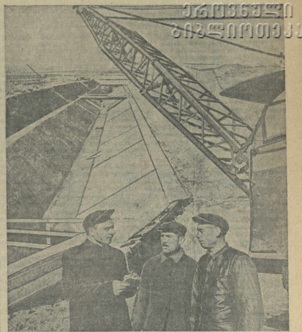
На строительстве Нижне-Магистрального канала в Самгори. На снимке (слева направо): главный механик «Самгорводстроя» Д. Бабулдзе беседует с экскаваторщиком Г. Чеддзе и Г. Карасашвили.
