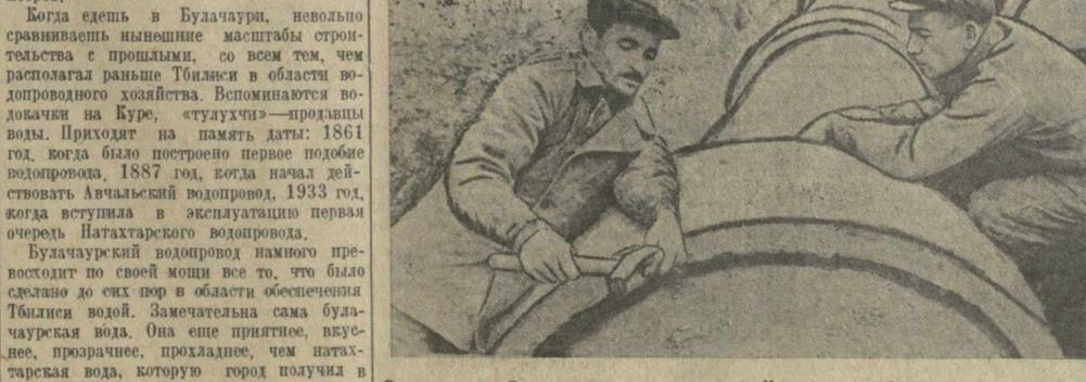
Строительство Булачаурского водопровода. На снимке: работа чеканщиков, выполняющих одну из завершающих производственных операций на участке в Сагурамской долине. На переднем плане (слева направо): Г. Заридзе и А. Карапетян.
