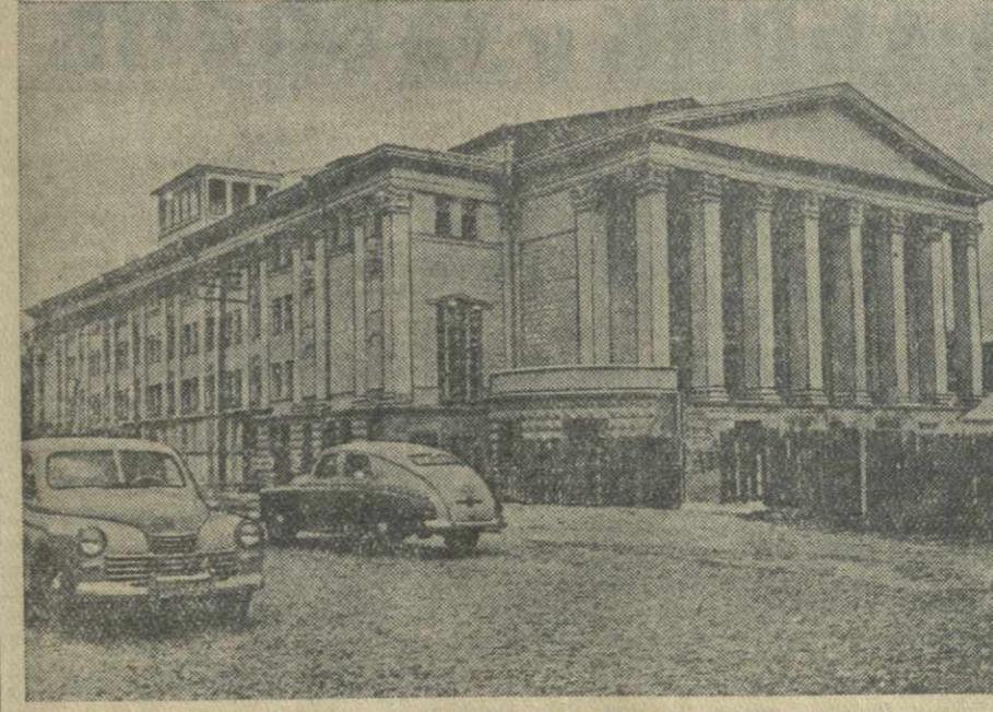
Батуми. Здание строящегося городского драматического театра. Фото В. Черкасова.
