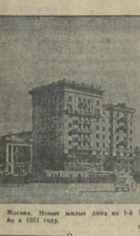
Москва. Новые жилые дома на 1-й Мещанской улице. Строительство закончено в 1951 году.
