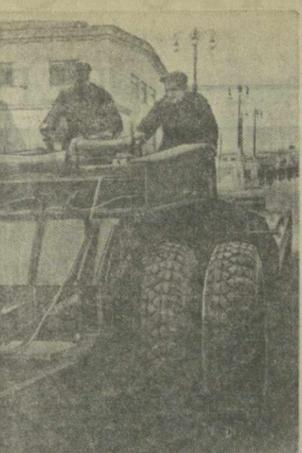
Киев. Завод «Красный экскаватор» выпускает многоковшовые экскаваторы, 20-тонные трайлеры и другие машины. На снемке: бригадир хеха сборки П. Е. Корчинский (слева) и слесарь Ф. З. Деркач за сборкой 20-тонного трайлера.
