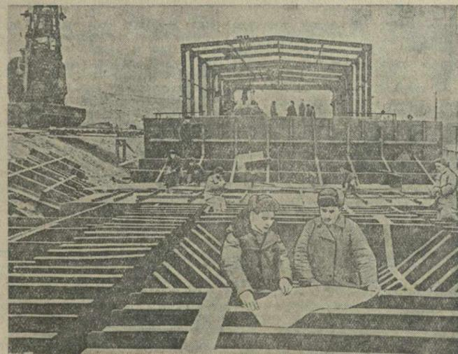
Запорожье. Коллектив Днепровского управления треста «Гидромонтаж» ведет сборку мощных земснарядов для строительства Каховского гидроузла. На снимке: начальник участка сборки земснарядов М. С. Приходько (слева) и бригадир монтажников И. С. Каспоров на сборке металлических узлов земснаряда 1000-80. Фото А. Красовского. Фотохроника ТАСС.
