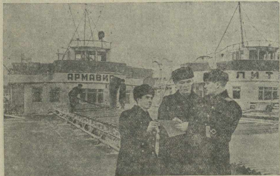
Куйбышев. Речники волжского грузового пароходства готовятся к навигации. Большинство судов, выделенных для плавания по Волго-Донскому каналу, отремонтировано и готово к эксплуатации на новой магистрали. Коллектив теплохода «Армавир» одним из первых досрочно подготовил судно к навигации. На снимке: в затоне Куйбышевского судоремонтного завода. На переднем плане — передовики социалистического соревнования члены команды теплохода «Армавир» (слева направо) боцман В. А. Бесчастнов, механик А. С. Ларин и капитан И. П. Герасимов. Фото М. Клименкова Фотокорника ТАСС.
