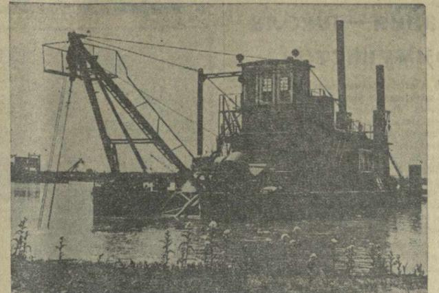
Новосибирская область. Ширится фронт работ на строительстве Новосибирской ГЭС. Мощные земснаряды ведут намытые плотины. За сезон в тело плотины они намоют полтора миллиона кубометров грунта. На снимке: мощные земснаряды в работе. Фото В. Лещинского. Фотохроника ТАСС.
