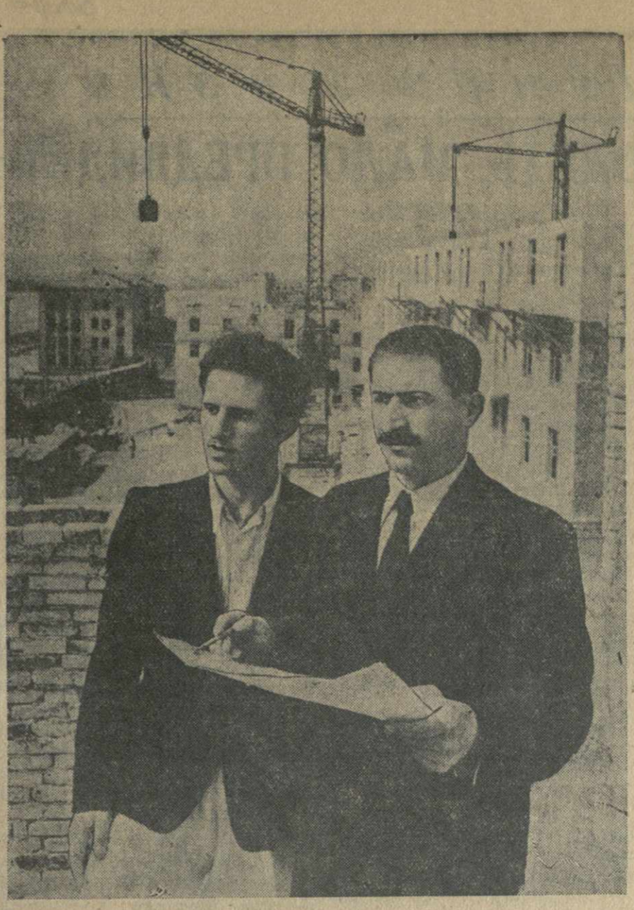
На стройках Сталинграда работает много посланцев братских республик. Среди них и специалисты из Грузии. На снимке: воспитанники тбилисских вузов инженеры И. Небридзе (справа) и И. Аробелидзе на строительстве 84-квартирного жилого дома. Фото М. Квирикашвили.
