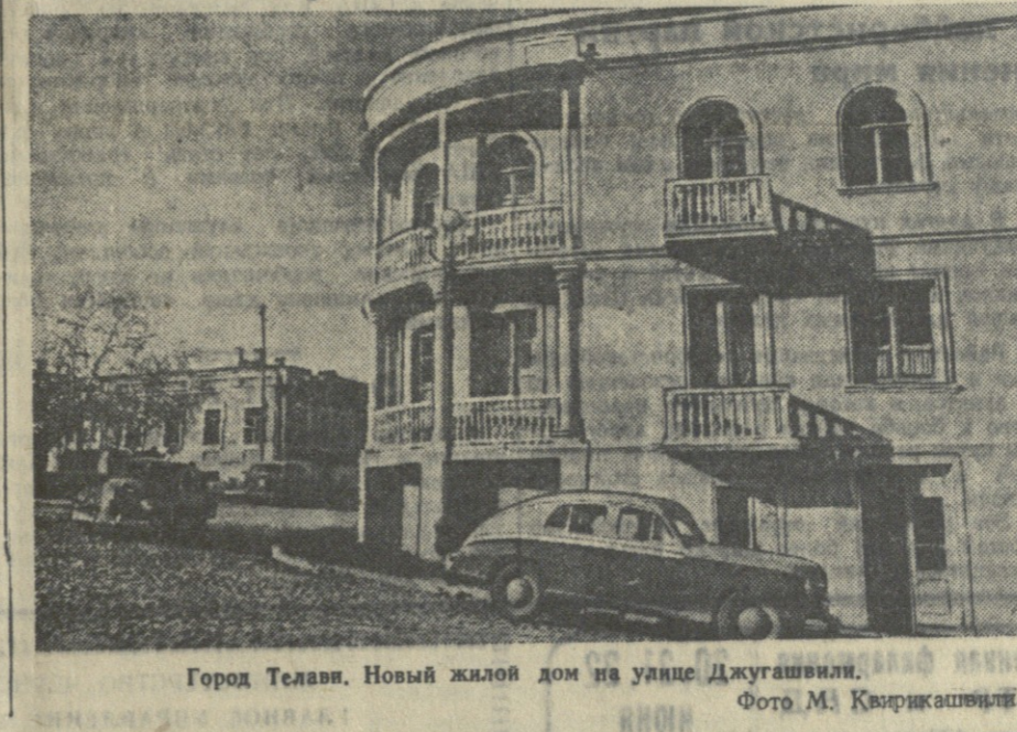
Город Телави. Новый жилой дом на улице Джугашвили. Фото М. Кварикашвили.
