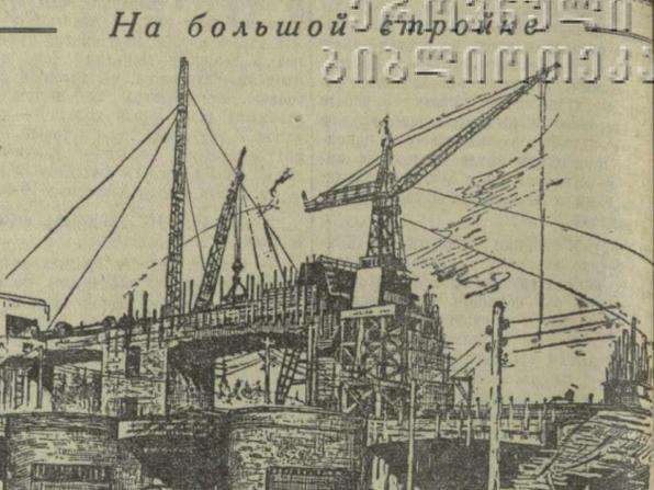
Огни электростанции прорезают спускающиеся по ночам на Курю осенние туманы. Яркое вспыхивают «молнии» сварочных аппаратов, грохочет и лязгает железо. Днем и ночью кипит работа на стройке Ортачалской гидроэлектрической станции. У строителей — горячая пора. Усиленными темпами ведутся монтажные и отделочные работы, предшествующие пуску первого агрегата. Подходят к концу сборка турбогенератора. Его пробную прокрутку строители намечают произвести в середине ноября.
